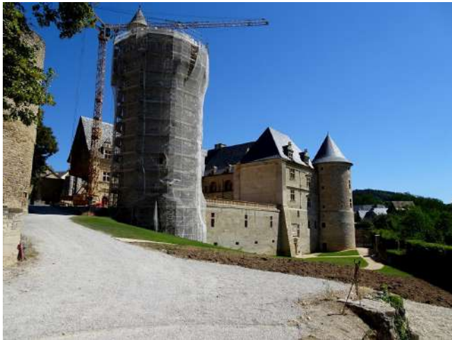
La Tour intérieure en cours de restauration
